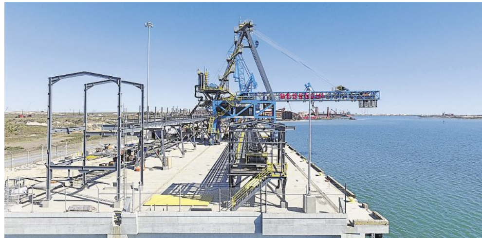
Die HBI-Anlage der Voestalpine in Texas, Baufortschritt Februar 2016.
